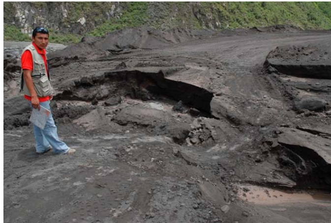
Figura 7: Vía inhabilitada producto de grandes flujos de agua lodosa Q. Romero. Foto: (Beth Bertel OVT)
