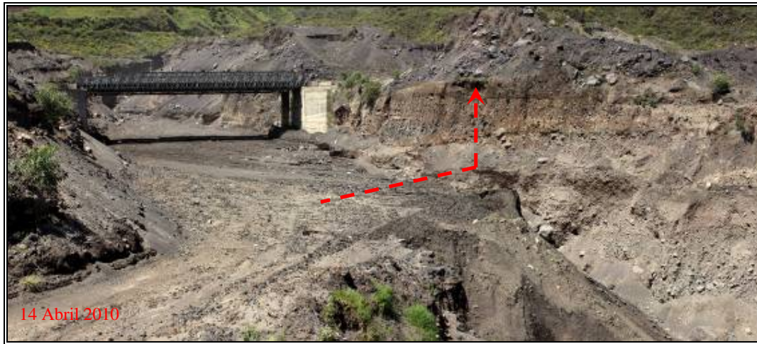
Figura 13: Entre el 10 de marzo (foto arriba) y el 14 de abril (foto abajo), la erosión regresiva causada por el tránsito de lahares de magnitud moderada durante este período ha producido un retroceso de el límite del cambio de pendiente hacia el R. Pastaza de más de 10 m, como lo indican las marcas de referencia en rojo (Fotos: P. Ramón-OVT/IG)
