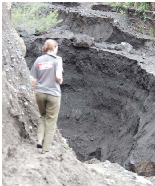
Figura 4: Vista de la quebrada Pingullo, con el socavón realizado por los lahares. Foto: M. Ruiz (IG-OVT-EPN)
