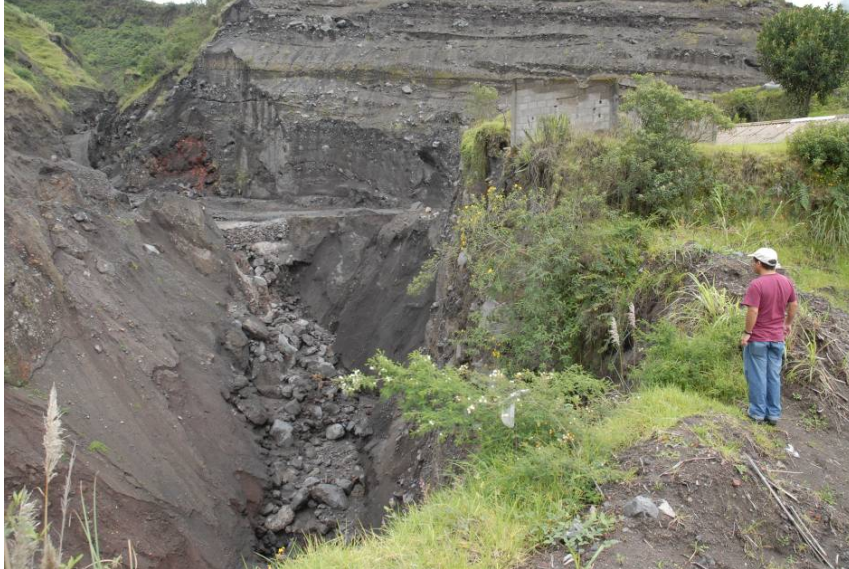
Figura 3: Socavamiento del cauce de la quebrada Bilbao. Atrás se observa el paso que se encuentra junto al lecho del río. Esta parte está reforzada con gaviones para disminuir la erosión regresiva.
