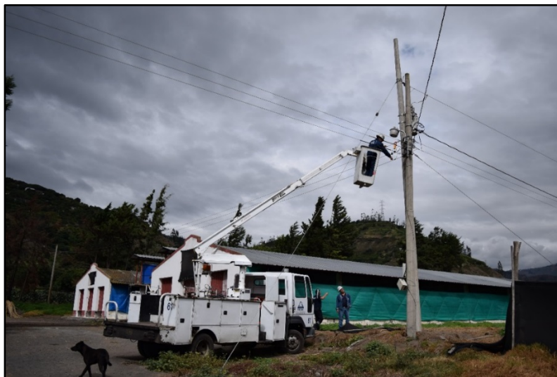
Figura 3. Técnicos de la empresa eléctrica trabajando en la recuperación de electricidad para el OVT (Foto: F. Vásconez-OVT-IG)
