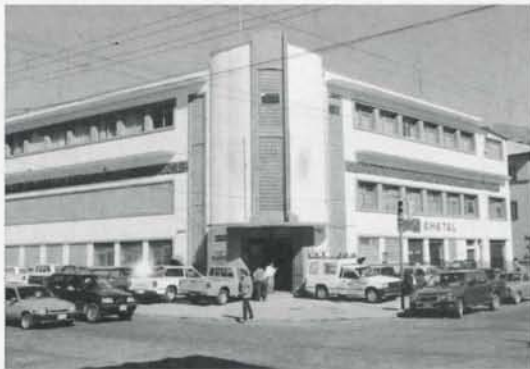
CENTRAL DE TELECOMUNICACIONES
