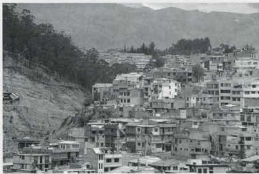
LADERAS SUSCEPTIBLES A DESLIZAMIENTOS
