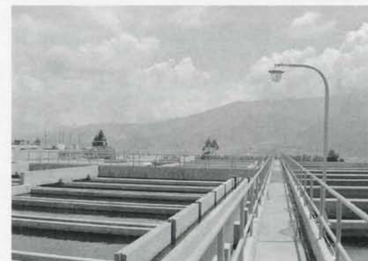
PLANTA DE TRATAMIENTO DE AGUA
