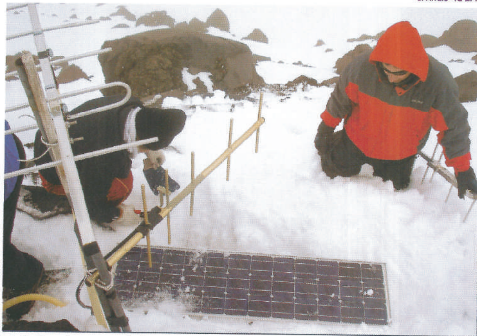
Trabajos de mantenimiento, estación sísmica Volcán Cotopaxi.
