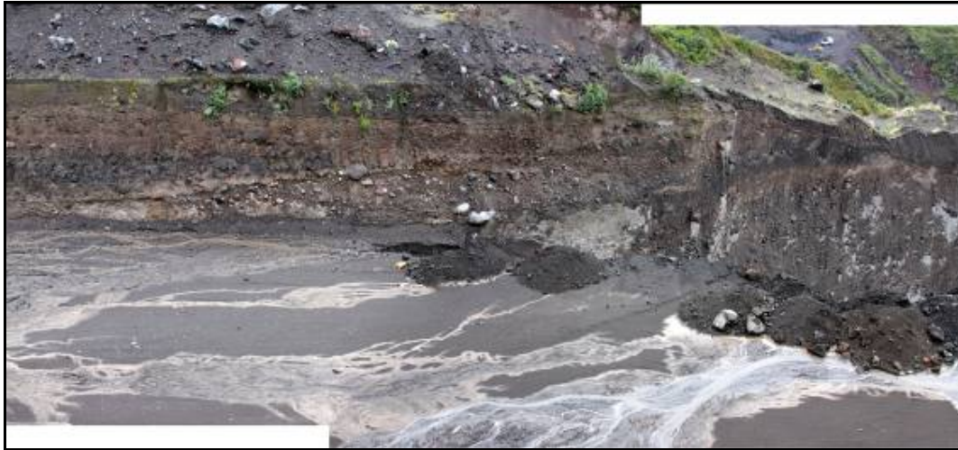
Figura 7: En el sector de los puentes de La Pampa se observa que descendieron pequeños flujos de agua lodosa, no se nota un incremento de la erosión regresiva (Foto: P. Ramón-OVT/IG)
