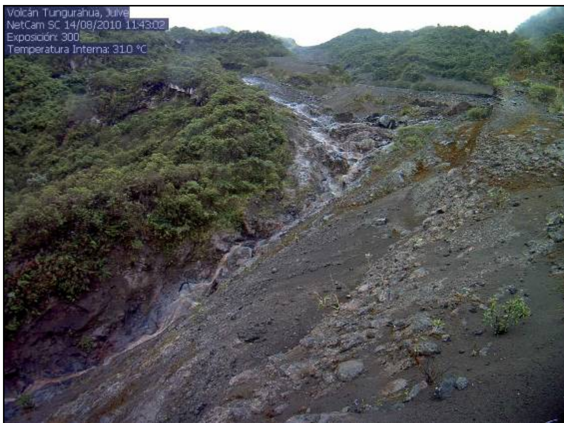
Figura 4: Imagen de la cámara de video instalada en la Q. Juive Grande, se observa el descenso de un pequeño caudal de agua lodosa
