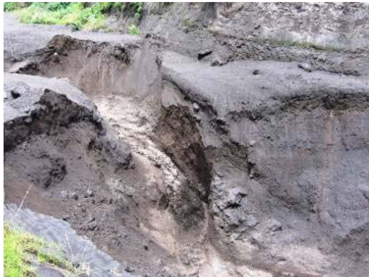
FOTO 6: Erosión causada por los diferentes flujos de lodo en la quebrada Pingullo (Foto J. Bustillos).
