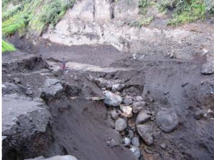
FOTO 5: Depósito del lahar ocurrido en la madrugada. Nótese la erosión producida en el cauce, la misma que impide el paso vehicular (Foto J. Bustillos).
