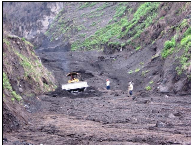
FOTO 6.- Lahar que descendió por la Q. Mandur y obstaculizó el paso en la carretera Baños-Penipe. Maquinaria pesada con personal de la Defensa Civil trabajando en habilitar el paso. (Foto: J. Bustillos)
