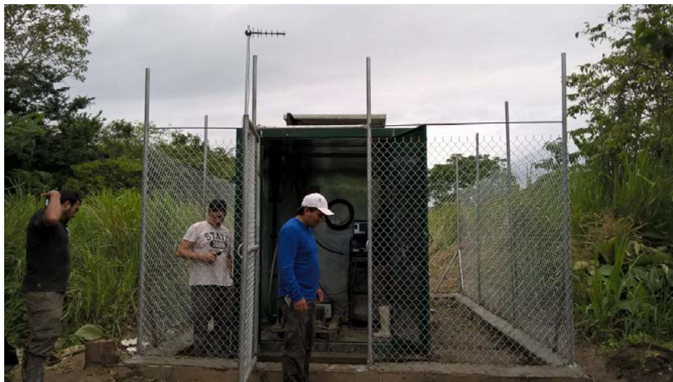
Fig 4: Instalación de enlace Cumilínche- Pta Galera y reubicación estación satelital.
