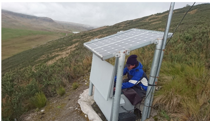
Fig. 7: Trabajos de calibración de sensor estación Antisana Mica
