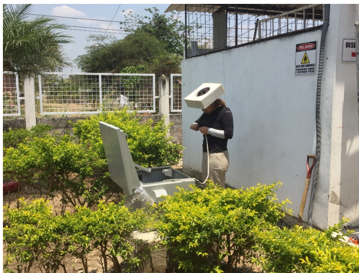
Fig 5: Instalación estación Pedro Carbo.
